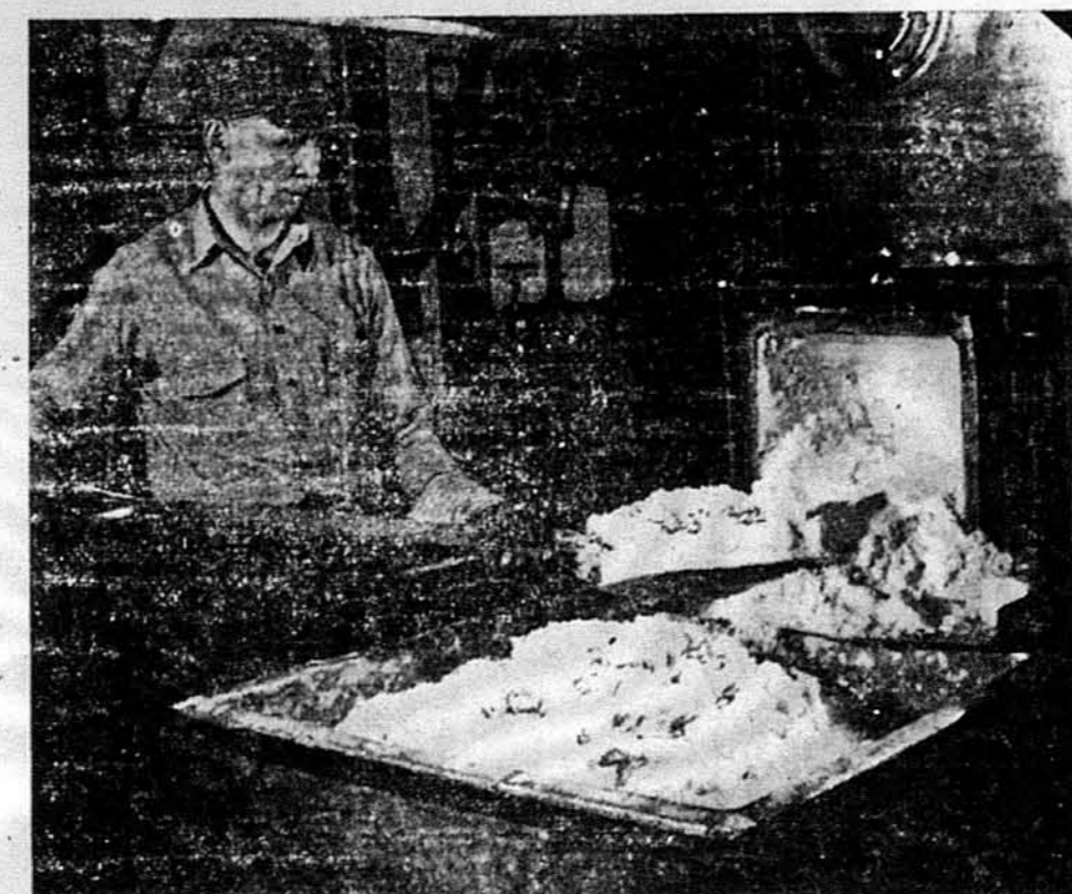
ЧИМ НАПИХАЮТЬ „РОЗБИВАЧІВ БЛЮКІВ“. Біла, кришталева субстанція, що виглядає як зернистий цукор, це вибухова матерія, що її набивають у ті великі бомби, з котрих кожна може розбити цілий блок будинків. Називають її гексаміною, а роблять її в фабриках Дю Понта в Перт Амбю, Нью Джерзі.
