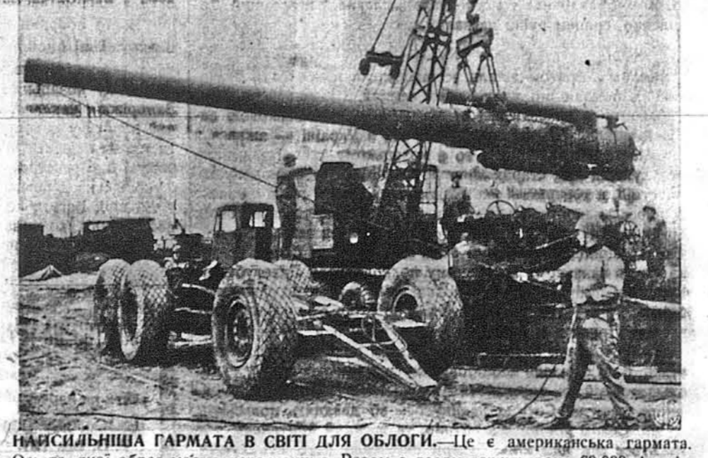
НАЙСИЛЬНІША ГАРМАТА В СВІТІ ДЛЯ ОБЛОГИ. — Це є американська гармата. Ось та, якої образ маємо перед очима. Разом з возом важить вона 69,000 фунтів. Вона вже добре випробувана. Тепер ладують ці гармати на залізницю, щоб відвезти в місця призначення для дальшого транспорту.
