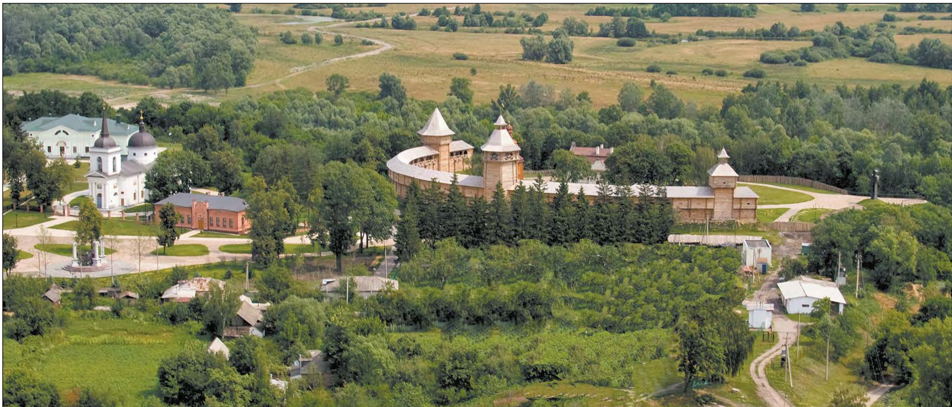
Реконструйовані зрубні стіни й вежі цитаделі фортеці Батурина XVII ст. (Аерофото: Сергій Чирін)
