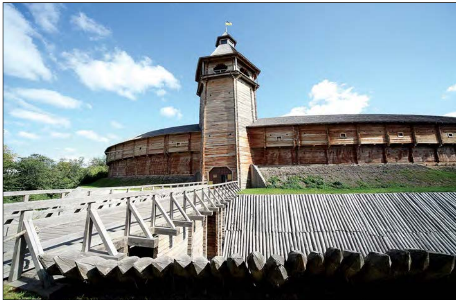
Рів з мостом, вал зі зрубною стіною та вежа з брамою цитаделі Батурина XVII ст. Реконструйовано за археологічними даними у 2008 року. (Фото: Микола Турчин).
