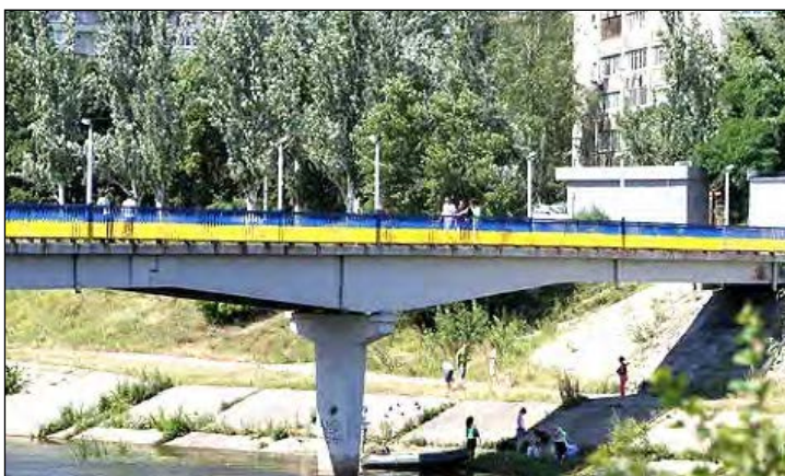
Синьо-жовтий міст на київській Русанівці. (Фото: „5 канал“)
