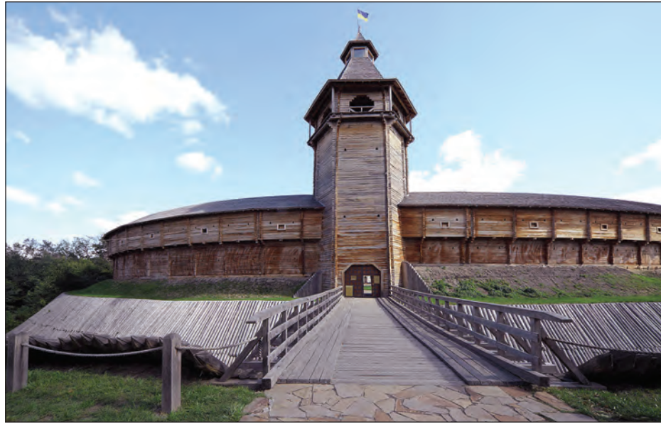
Зрубні стіни, вежа з брамою, міст, вали й рови цитаделі фортеці Батурина XVII ст. Реконструйовано на базі археологічних даних у 2008 році. (Фото: Миколая Турчин)
