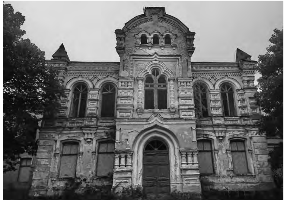
Напівзруйновна будівля Златопільської гімназії.
