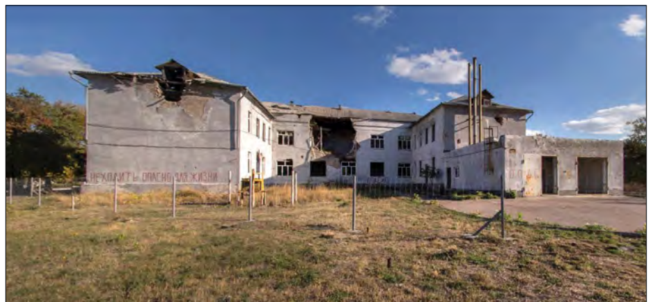
Зруйнований будинок неподалік центру міста.
