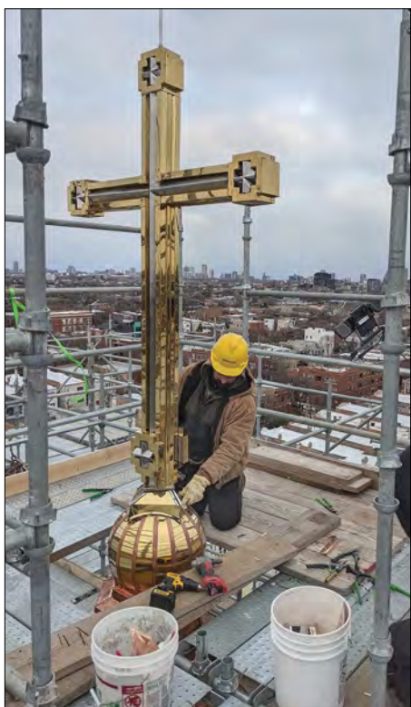
Встановлення нового хреста.
