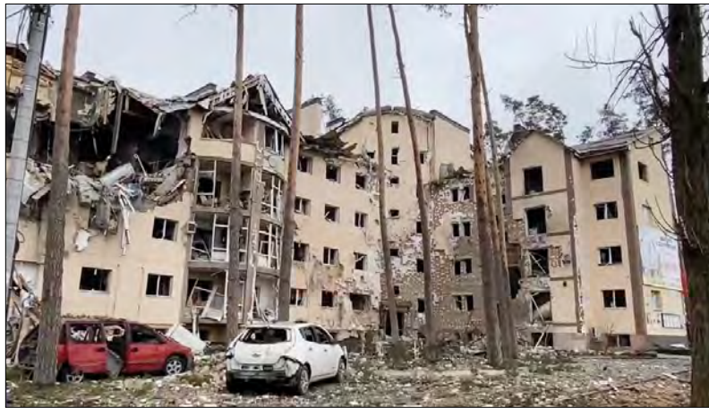
Будинки в Ірпені після обстрілу 2 березня.
