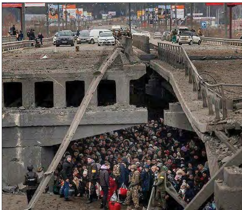
Мешканці Ірпеня шукають порятунку під руїною мосту.
